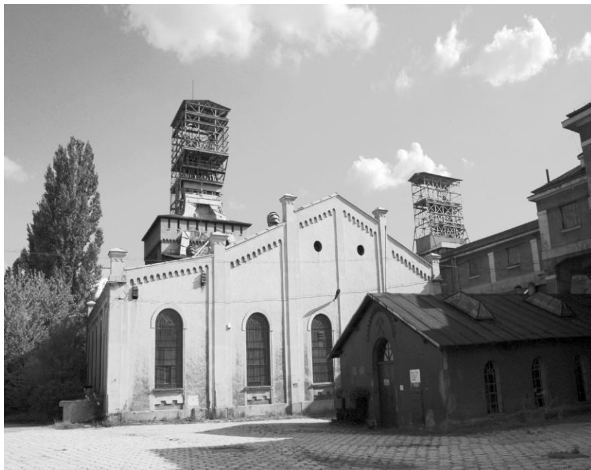
Fotografia 1. Szyb górniczy typu Malakow w Kopalni „Julia”
